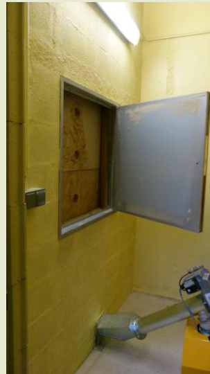
Chaufferie bois à pellets
