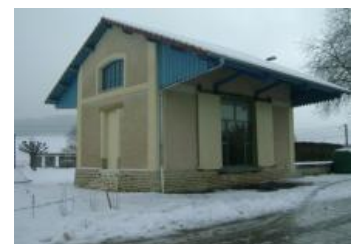
L'ancienne halle de gare de Maxey-sur-Meuse : Prix Départemental des Vosges
