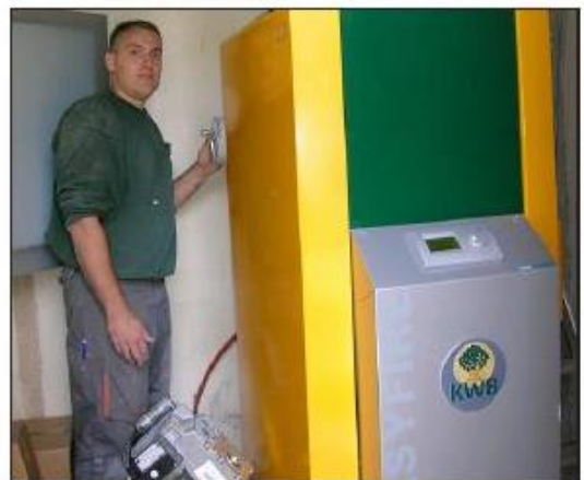
■ Fabrice Pescheloche installe le chauffage de nouvelle génération.
