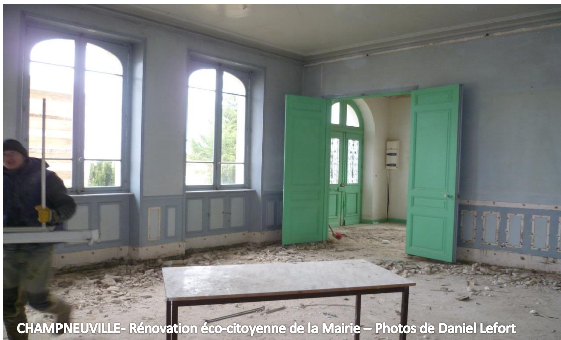
CHAMPNEUVILLE- Rénovation éco-citoyenne de la Mairie – Photos de Daniel Lefort
